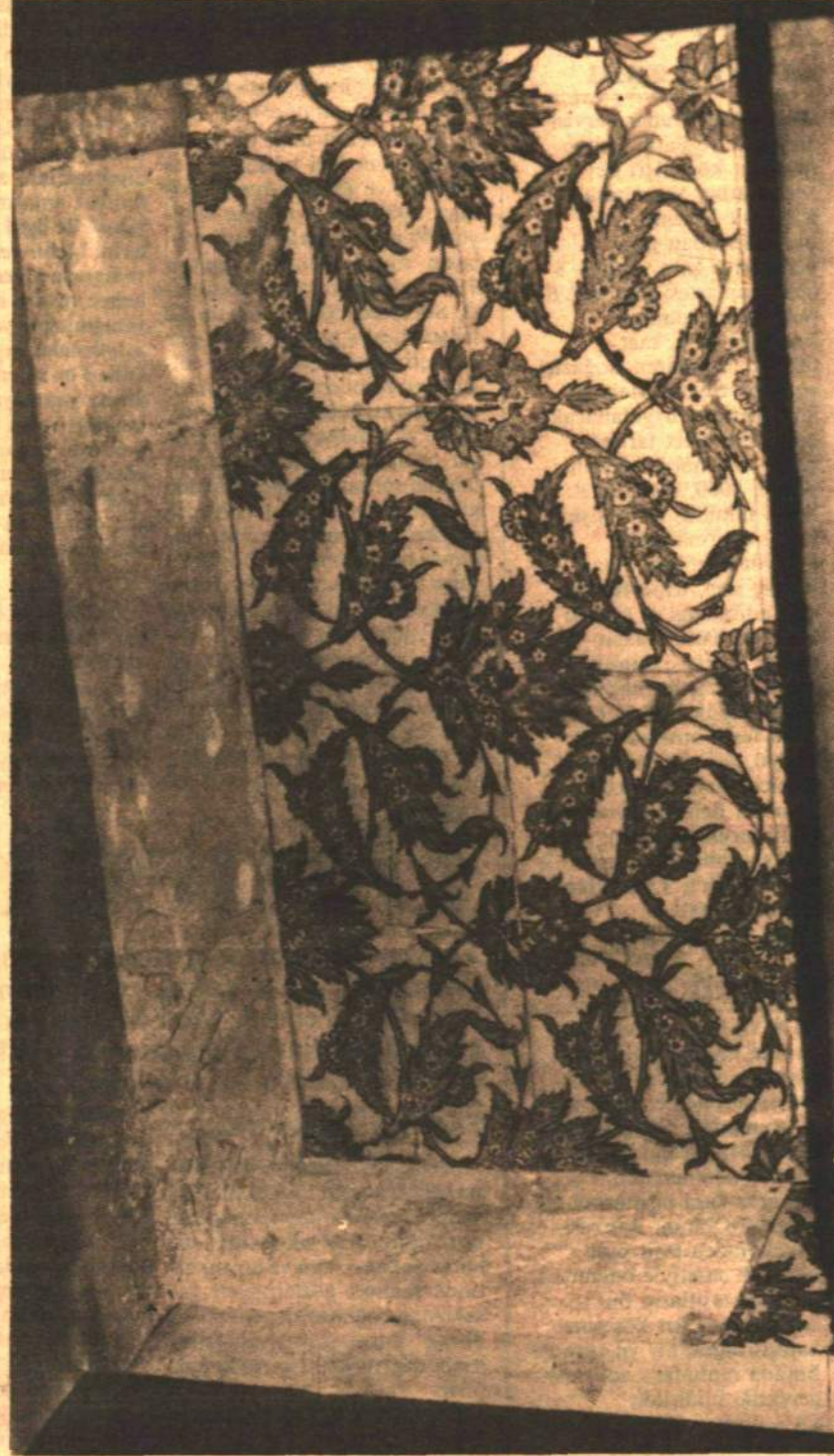
KALANLAR — Sökülün çinilerin sol tarafında kalan bölümün çinileri.
